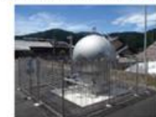
耐震性があり水道水を溜める機能を持った貯水槽に給水栓を設置した応急給水所
