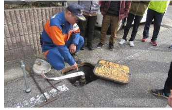
消火栓取扱いの説明
