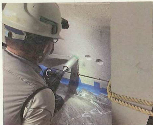
壁材の試料採取の状況
