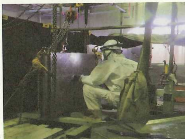
設備の解体・切断状況
