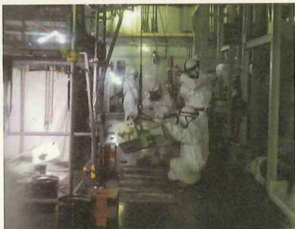
裁断破碎エリアの解体撤去の状況
