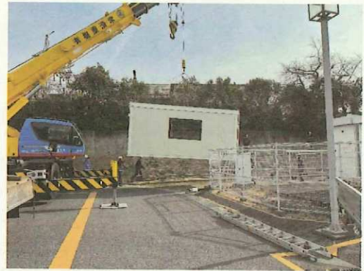
仮設工事事務所の設置状況
