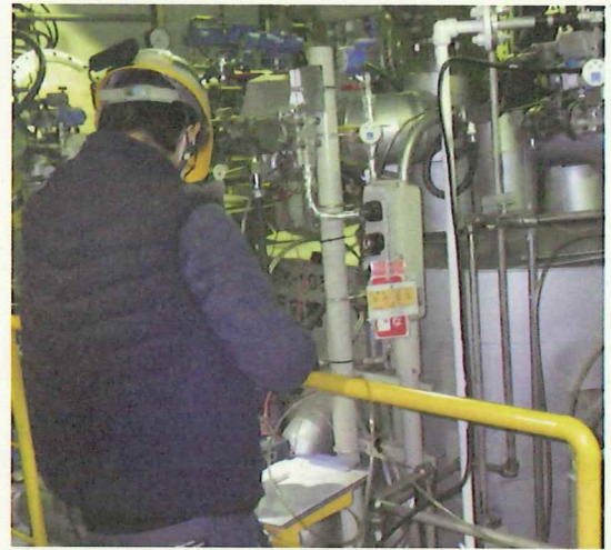
液処理設備の点検
