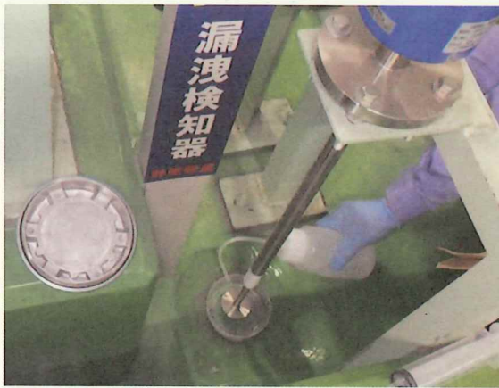
漏洩検知器の作動試験
