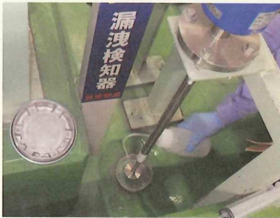
漏洩検知器の作動試験
