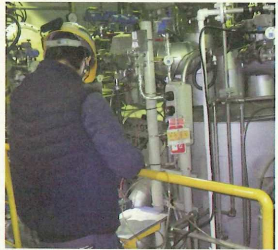
液処理設備の点検
