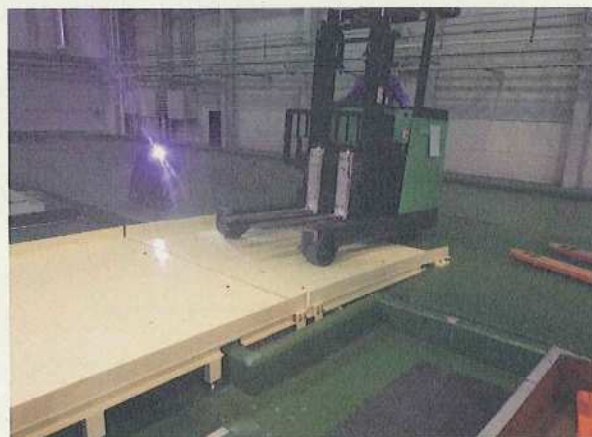
廃棄物保管、搬出のためのスロープ設置
