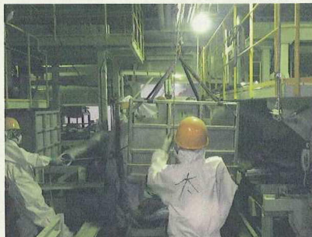
解体設備周辺の不要物の撤去作業
