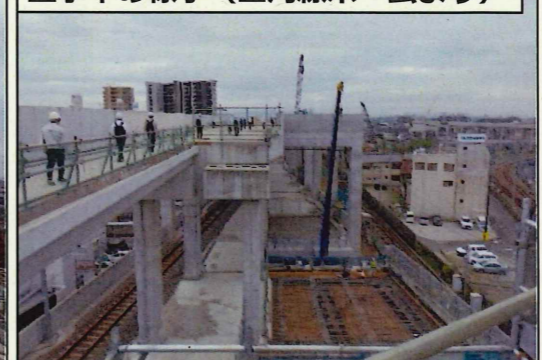
工事の様子（三河線ホームより）
