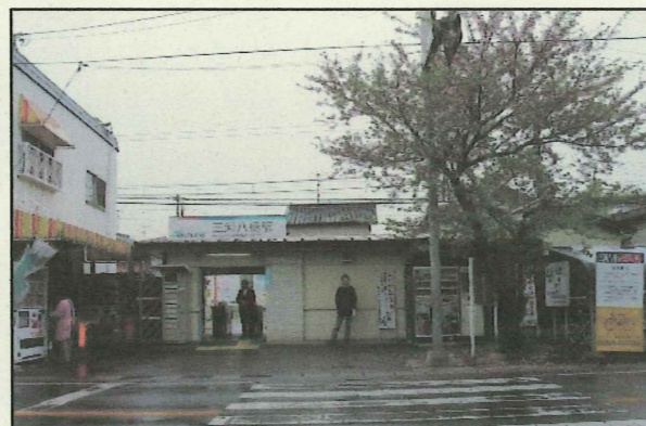
高架化工事着手前に撮影（平成15年）
