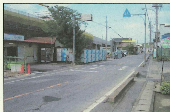
高架化工事に撮影（平成21年）
