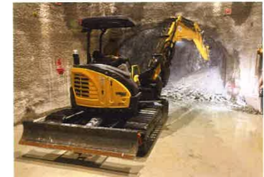
バケットンネル掘削状況
