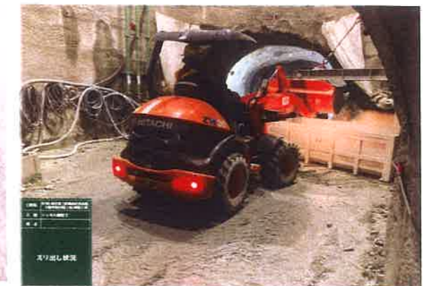
トンネル施工状況
