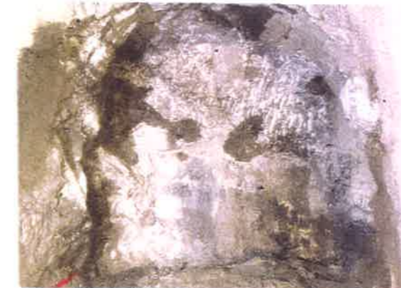
切羽(トンネル先端)の状況 (83.4m位置) トンネルの施工は、飯野川の直下を通過しました。
