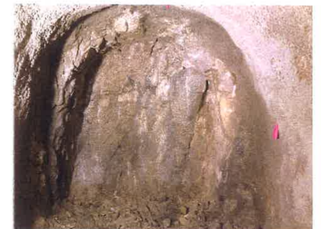
切羽(トンネル先端)の状況(439.4m位置)
