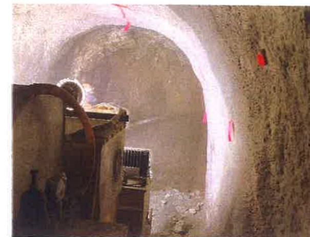
コンクリート吹付状況
