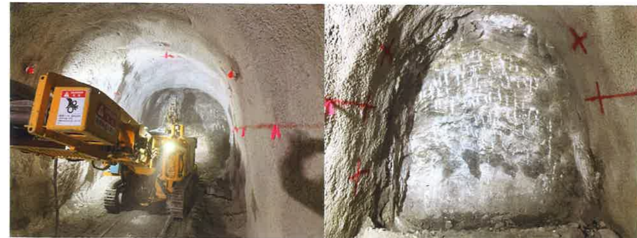
ずり出し状況
