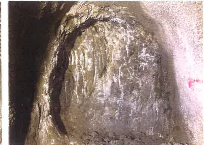
切羽(トンネル先端)の状況(483.4m位置)
