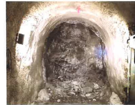
切羽(トンネル先端)の状況(164.4m位置)
