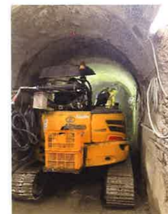
トンネル施工状況
