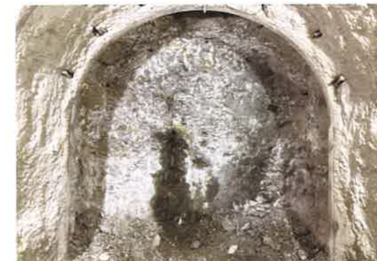
切羽(トンネル先端)の状況(60.2m位置)
